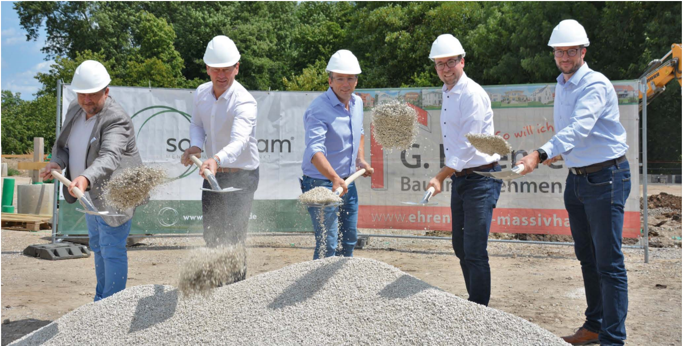
Bürgermeister Thomas Beer, Investor und Bauherr Dr. Thomas Rosenkranz, Bauunternehmer Georg Ehrenreich, Geschäftsführer Dr. Christian Weiß und Prokurist Andreas Neugirg vom Sozialteam beim Spatenstich. (Foto: Thomas Stegerer)
