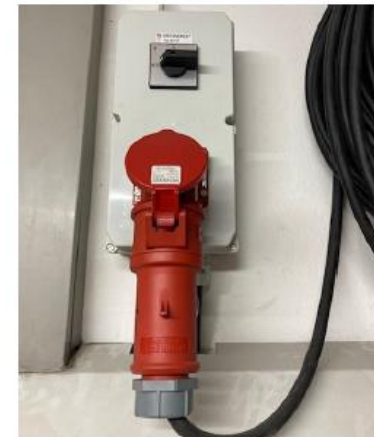
Abbildung 5: Not-Einspeisung Feuerwehrhaus
