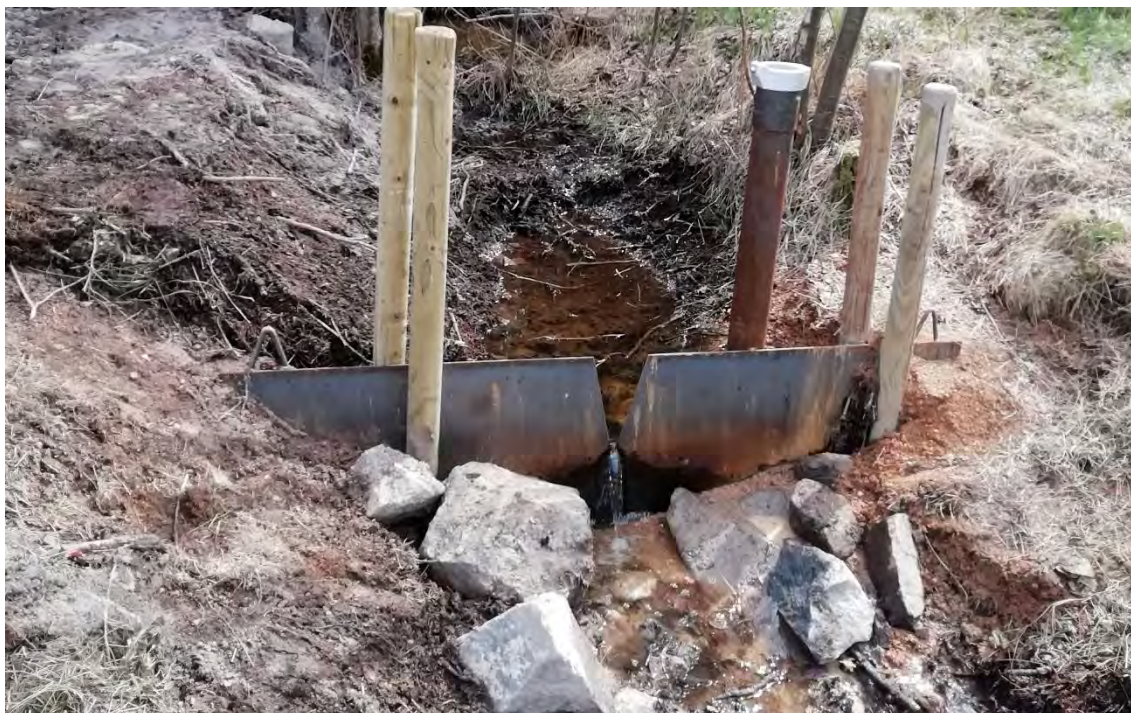
Foto 1: Einbau/Instrumentierung Messwehr am Namenlosen Graben am 15.04.2021
