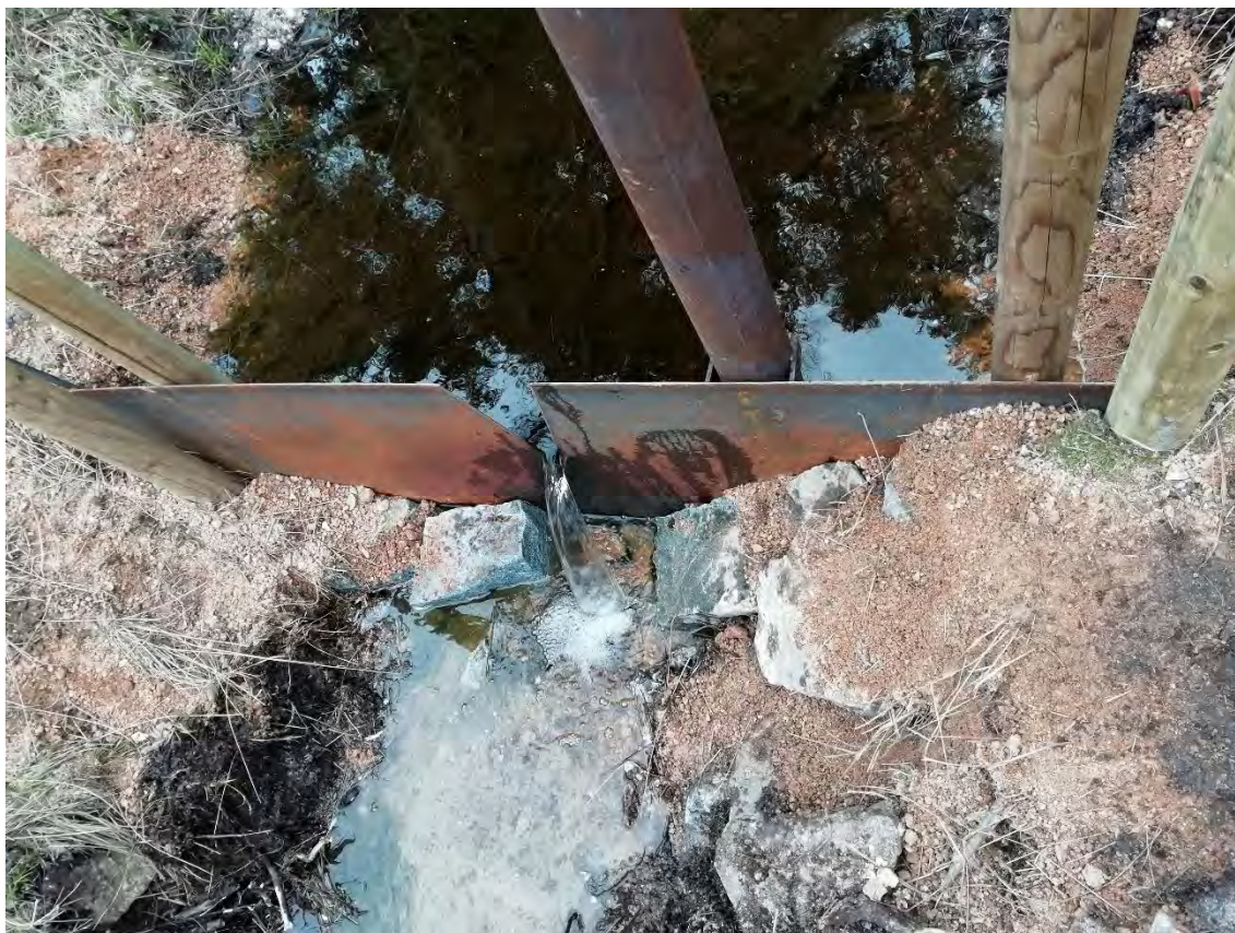
Foto 1: Einbau/Instrumentierung Messwehr am Bürgerweihergraben am 15.04.2021
