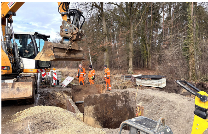
Seit Mitte Februar 2026 schreiten die Arbeiten an der neuen Fußgängerbrücke zum Wild- und Freizeitpark „Höllohe“ planmäßig voran. (Foto: Thomas Stegerer)
