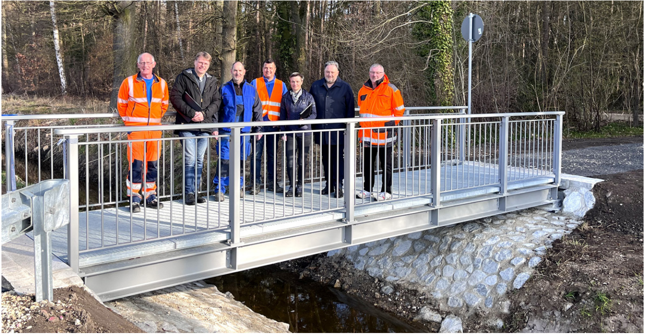
Bürgermeister Thomas Beer (2. v. r.) machte sich gemeinsam mit den Projektbeteiligten ein Bild von der neuen Höllohe-Brücke: Peter Roidl (Bauhofleiter), Tragwerksplaner Konrad Kraus, Josef Wilhelm (Fa. Metallbau Duschinger), Florian Schmidbauer (Fa. Strabag), Bauamtsleiterin Sabine Eichinger und Siegfried Frankel (Fa. Strabag) (vo. li. n. re.). (Foto: Julia Lösche)
