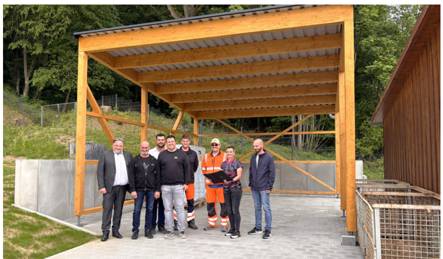
Bürgermeister Thomas Beer (li.) mit den Vertretern der beteiligten Baufirmen, den Mitarbeitern des Wasserwerks und des städtischen Bauamts beim neu errichteten Carport für die Unterbringung der Notstromversorgung am Wasserwerk Teublitz. (Foto: Thomas Stegerer)
